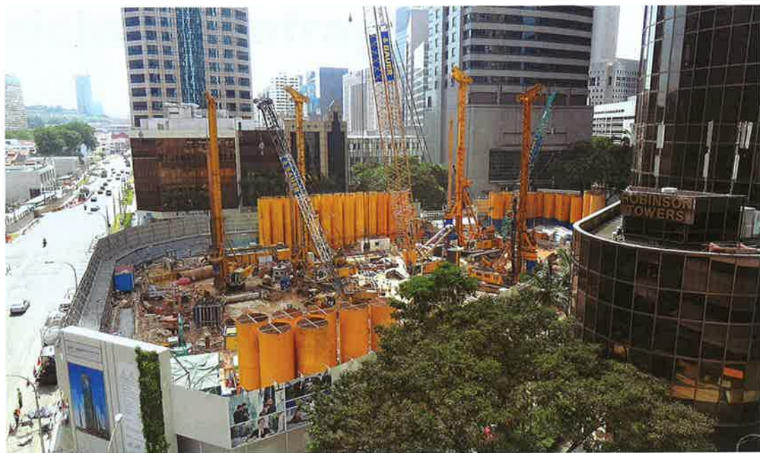
Beim Projekt „Market Street Tower“ in Singapur kamen Spezialtiefbaugeräte von Bauer zum Einsatz.
